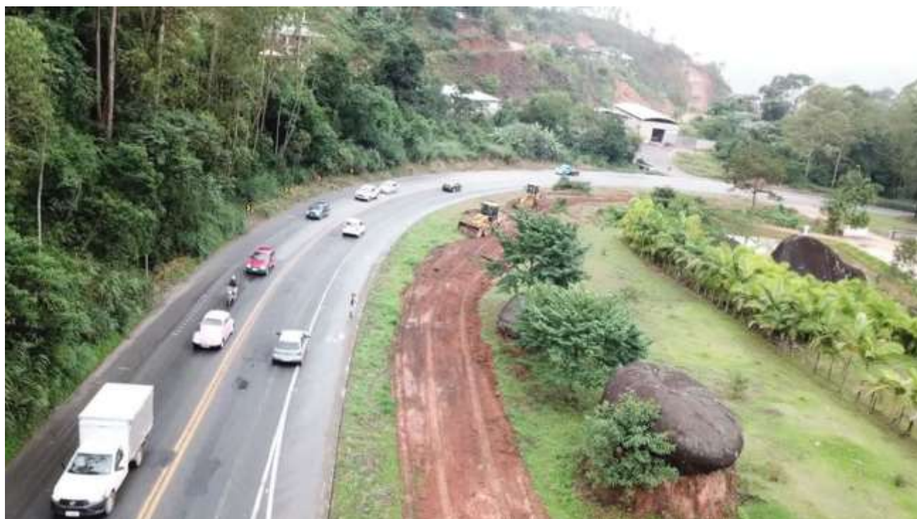
Fig. 1 – Imagem do início das obras de duplicação da BR 262
